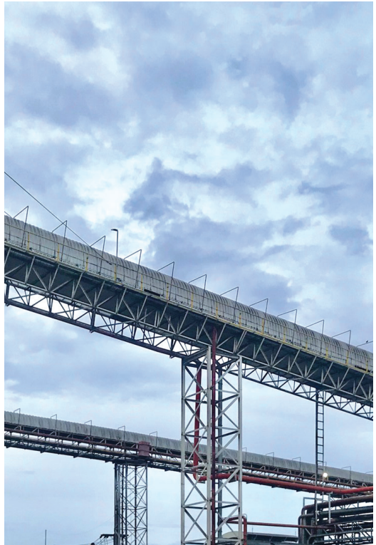
การควบคุมฝุ่นจากบริเวณจัดเก็บขามอ้อย เช่น สเปรย์น้ำเพื่อป้องกันการฟุ้งกระจายของขามอ้อย และติดตั้งที่ครอบสะพานลำเลียงขามอ้อย
