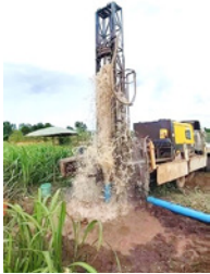
ส่งเสริมการเจาะบ่อนาดาลน้ำลึก
