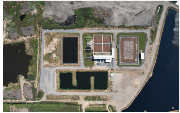
ระบบบำบัดน้ำเสียแบบตะกอนเร่งในพื้นที่อุทยานด่านช้าง
